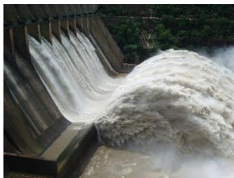
Gli impianti idroelettrici sfruttano le cadute di acqua per produrre energia elettrica. Sono costituiti generalmente da una turbina che ruota sotto la spinta di un flusso di acqua ad alta pressione convogliata da un condotto proveniente da una diga. La turbina è collegata ad un alternatore che trasforma l'energia meccanica di rotazione in energia elettrica
